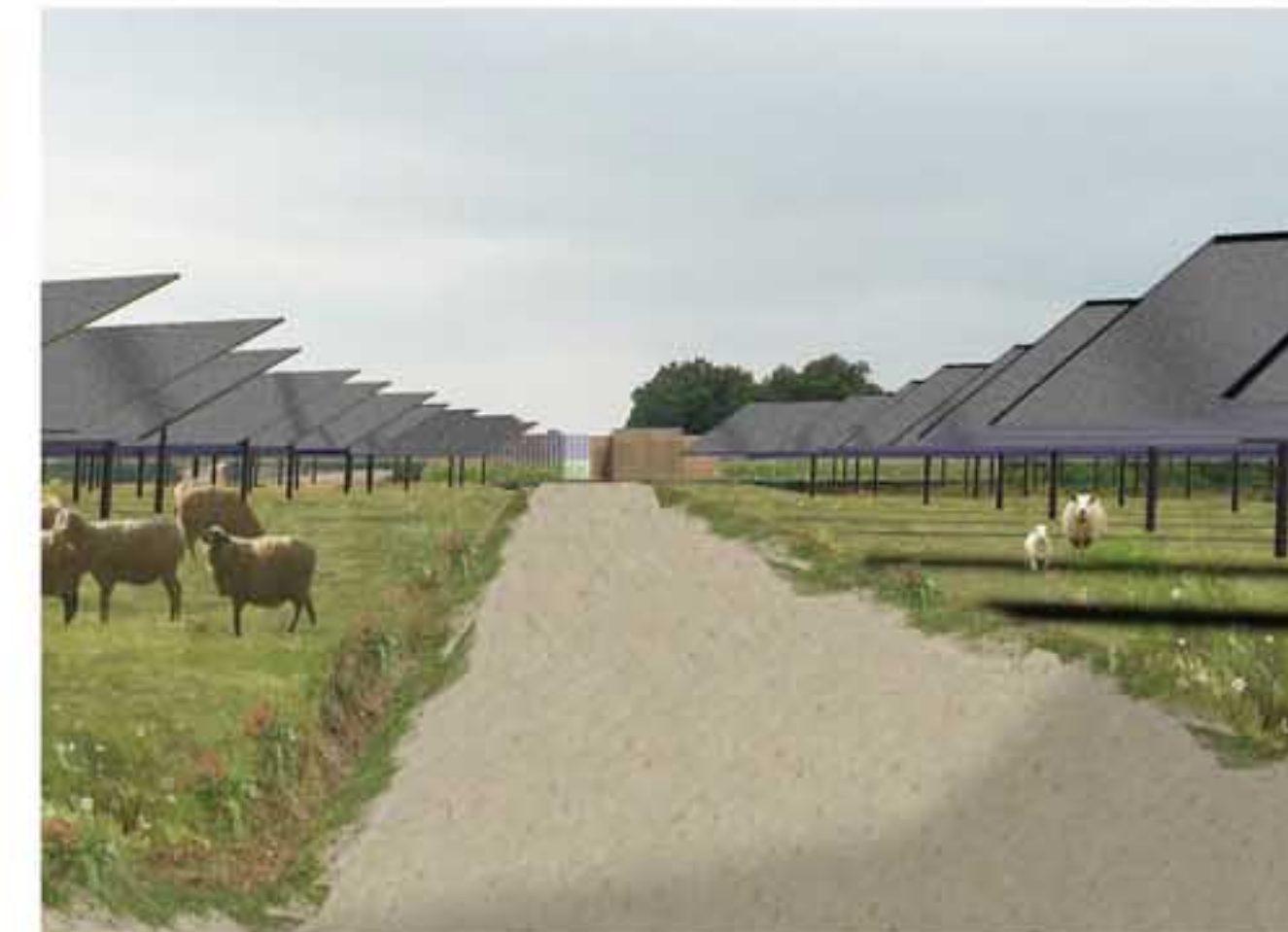
67 000 m 2 de panneaux photovoltaïques au silicium microcristallin-amorphe. Entretien du terrain par ovins.
